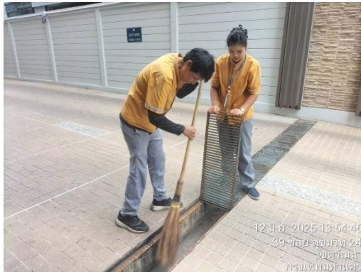
รูปที่ 2-54 เจ้าหน้าที่ชุดลอกทำความสะอาดรางระบายน้ำของโครงการ
